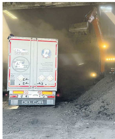
I TIR II via alla rimozione dei rifiuti nello Stir di Casalduni
