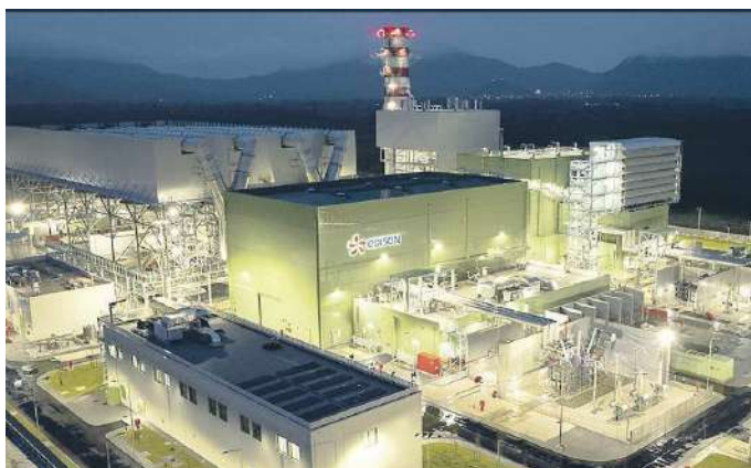
Una veduta notturna delle centrali termoelettriche a gas realizzate da Edison a Presenzano, in provincia di Caserta: è in grado di soddisfare il fabbisogno di un milione e mezzo di famiglie
