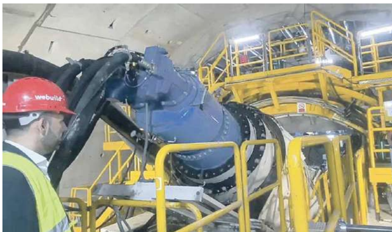
I lavori di scavo sul tratto appenninico della nuova linea ferroviaria che collegherà Napoli a Bari
