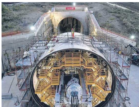
La talpa meccanica che ha scavato il tunnel Av Napoli Bari in valle Ufita e il rendering del progetto della piattaforma logistica
