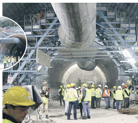
Il tunnel de «Le Forchie» con gli operai impegnati h24
