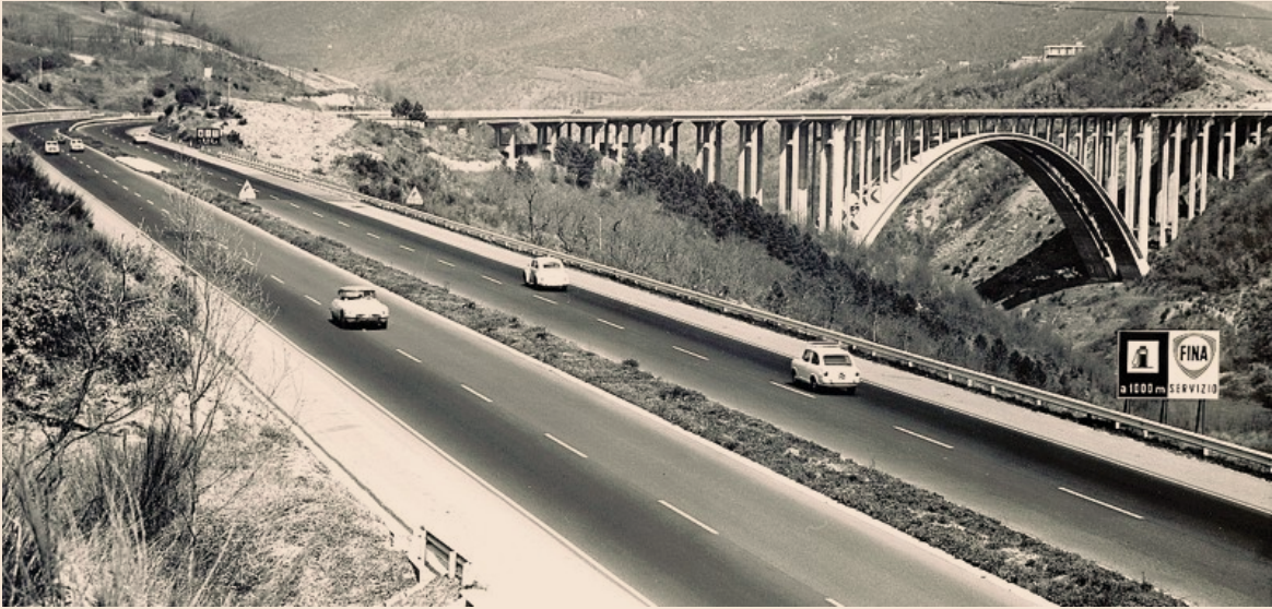
Opera simbolo. La A1 Milano-Napoli (autostrada del Sole) negli anni 70, in una foto dell’archivio storico di Mediobanca
