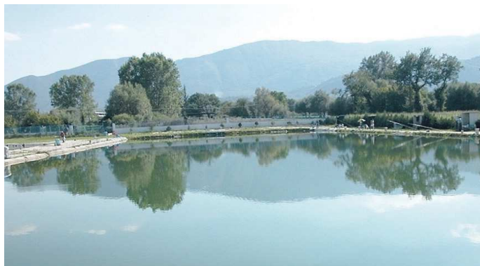
LA DIGA Le fonti molisane attraverso le quali viene inviata l'acqua nei territori del Sannio
