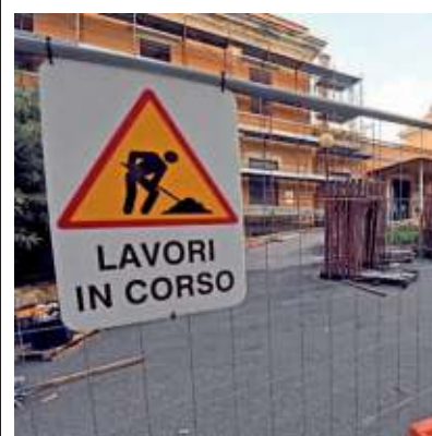
▲ Il cantiere La variazione dei valori catastali colpirà gli immobili ristrutturati con il 110%
