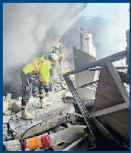
Un edificio distrutto da un attacco missilistico israeliano
