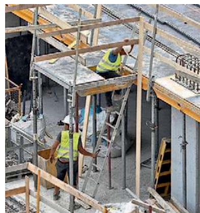
▲ I lavori Un cantiere edile
