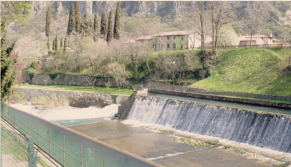
Nel vicentino. La centrale idrica di Oliero, la più importante di Etra, che attinge dal sistema carsico dell'Altopiano di Asiago
