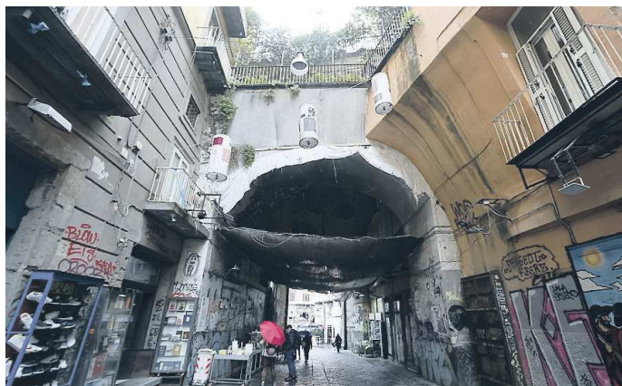
I LAVORI Da oggi parte il restyling dell'arco NEAPHOTO-R. ESPOSITO
