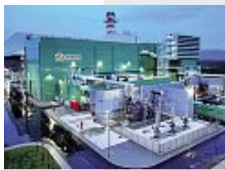
Il sito La centrale combinata Flavio Crescentini di Presenzano
