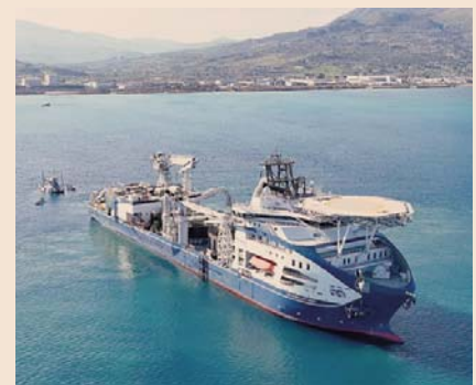
Infrastrutture. La nave posacavi Leonardo da Vinci di Prysmian
