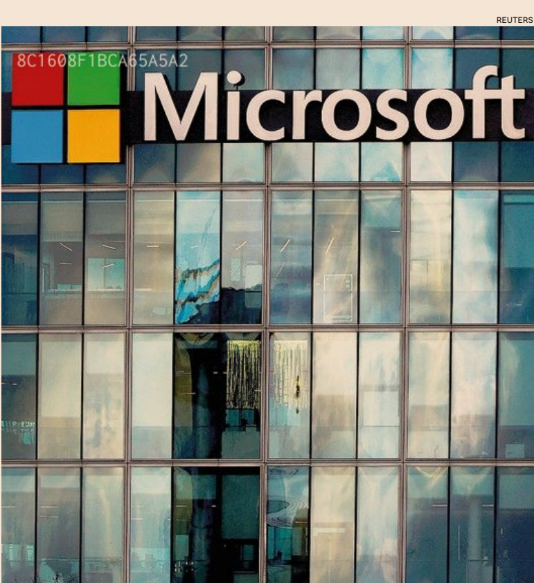
Cantieri aperti. Il più grande progetto di teleriscaldamento con data center è di Microsoft: in Finlandia soddisferà il 40% del fabbisogno di calore di Espoo, seconda città della Finlandia
