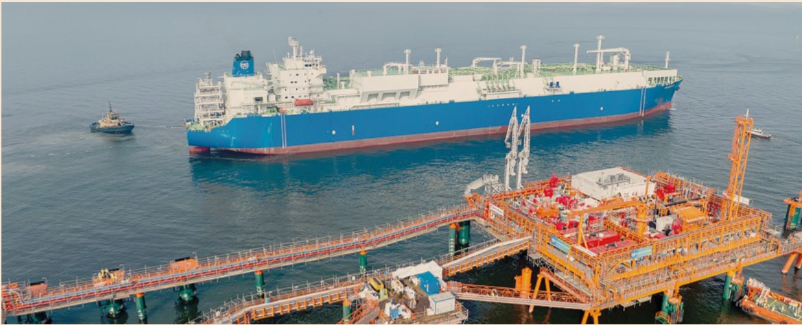
Infrastrutture. Il terminale di rigassificazione di Snam ormeggiato a Ravenna
