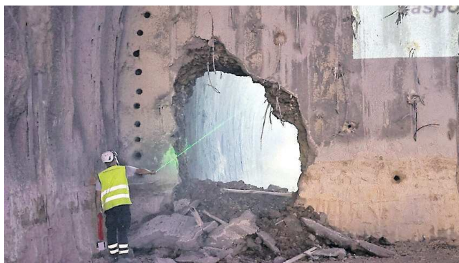
I LAVORI La Galleria naturale Ponte, nel tratto Telesse-Vitulano, per la linea AV/AC Napoli-Bari
