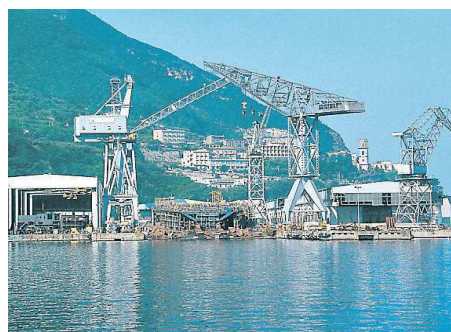
Il cantiere di Castellammare di Stabia
