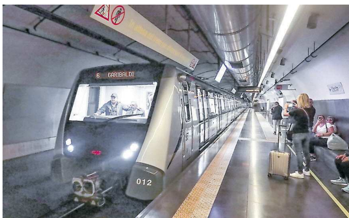
I DISAGI Il tunnel del metrò perforato ha provocato rallentamenti sulla linea 1
