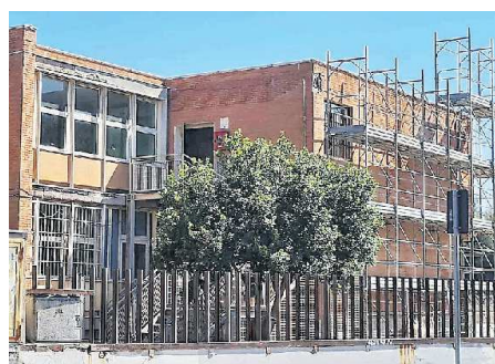
Una scuola in ristrutturazione
