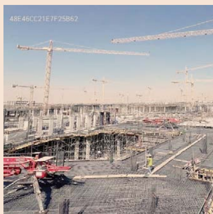
Giga Project. I cantieri del Diriyah Gate Development Project, che vede tra i protagonisti l'italiana WeBuild
