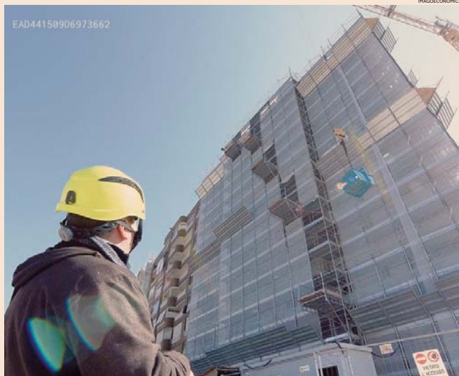
L'impatto. Le contestazioni rischiano di colpire i cantieri con lavori non terminati
