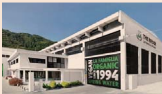
Esterno dello stabilimento
